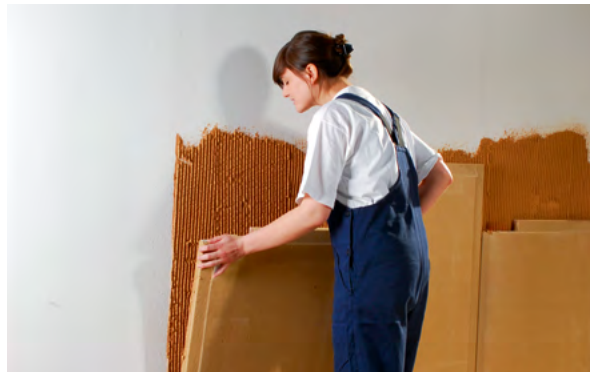
Die BKM LB-Klimaplatten können auch an das Mauerwerk geklebt werden (Untergrund beachten!)
