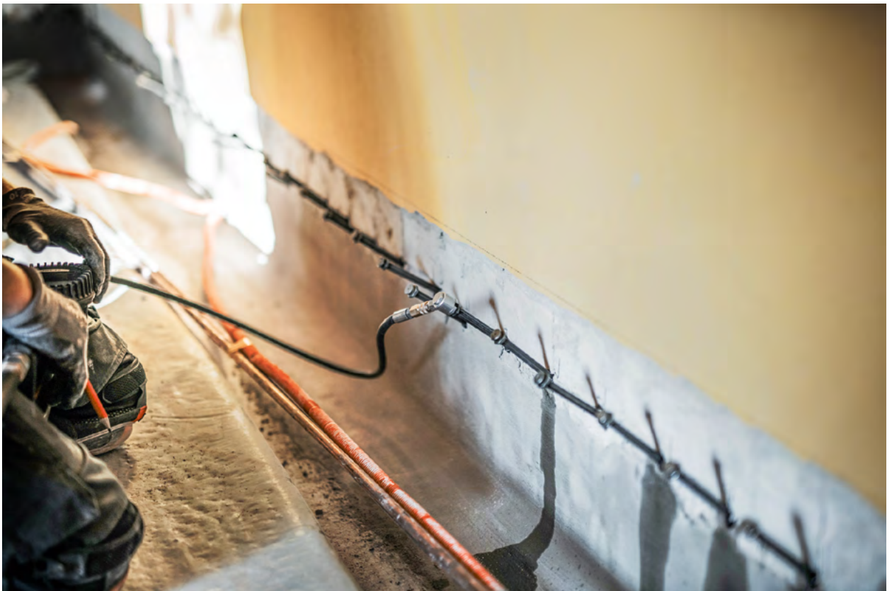
Niederdruckinjektion des Produktes mittels Verpresslanzen.
