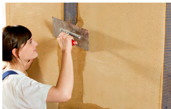
Der BKM LB-Spachtel wird nach Anleitung angerührt und in die Flachkante eingespachtelt.
