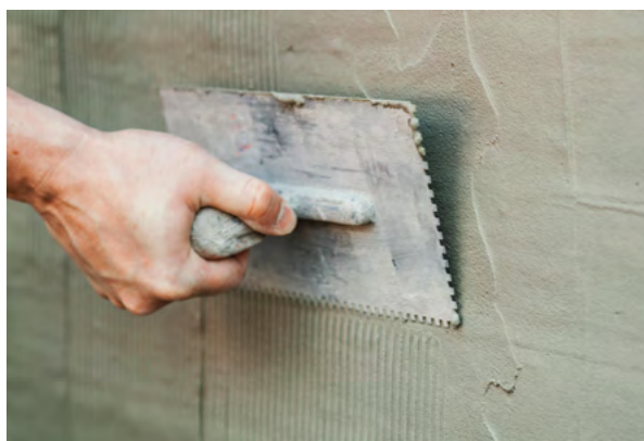
Dichtungsschlämme glätten
