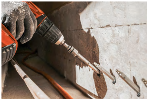
Erstellung einer Dichtkehle mit anschließender Verpressung des Harzes.
