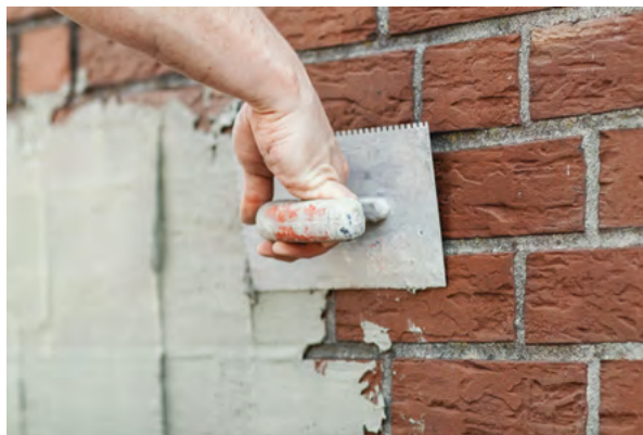
BKM DS 1K Dichtungsschlämme aufziehen
