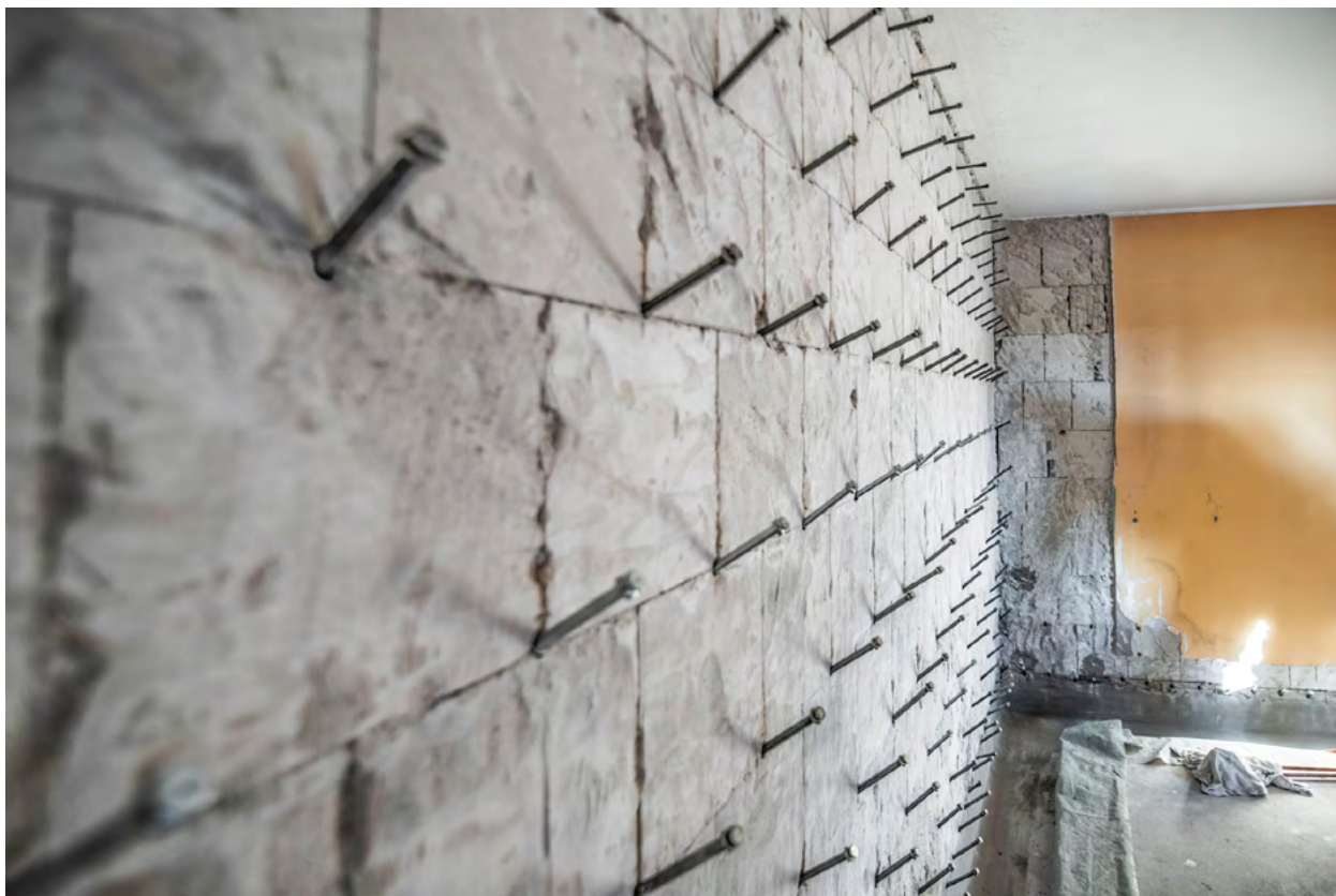
Die Verpresslanzen werden schachbrettartig an der betroffenen Wand angebracht.
