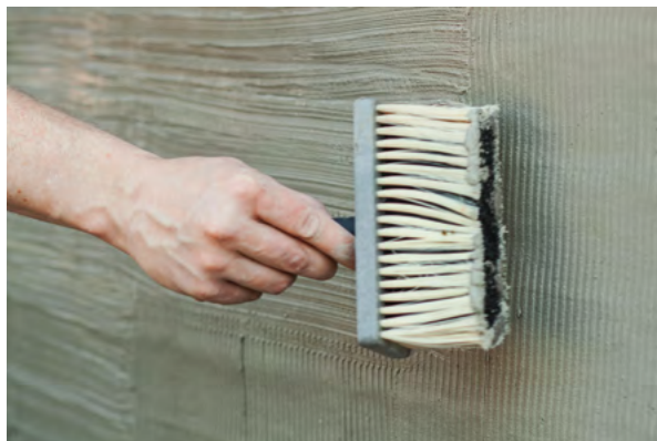
Dichtungsschlämme schlämmen
