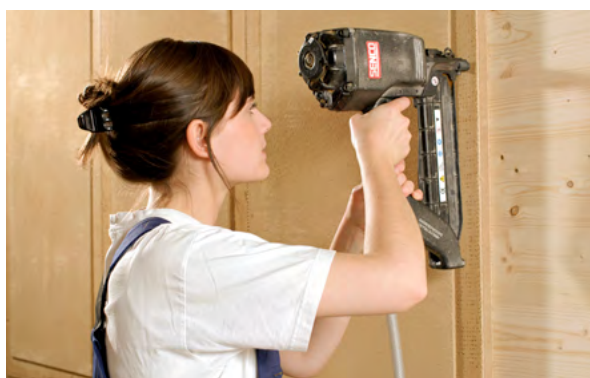
Die Lehmbauplatte wird in der Flachkante mit Trockenbauschrauben oder Klammern an die Unterkonstruktion befestigt.
